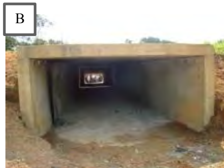
Figura. 1. (A) Corte e aterro em área de vegetação nativa para construção de rodovia. (B) proposta de passagem de fauna. Ação impactante que promove a perda de conectividade entre fragmentos. Fonte: CETESB/2010
